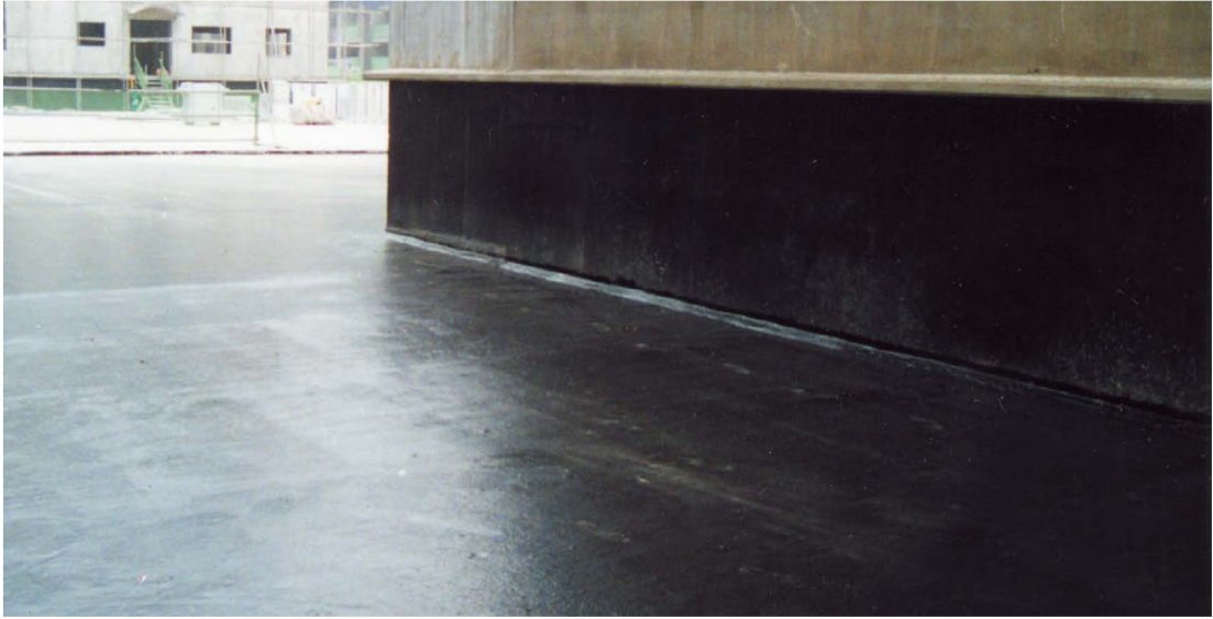
▲ 방학동 대상타운 지하주차장 상부 (면적 : 40,000㎡)
