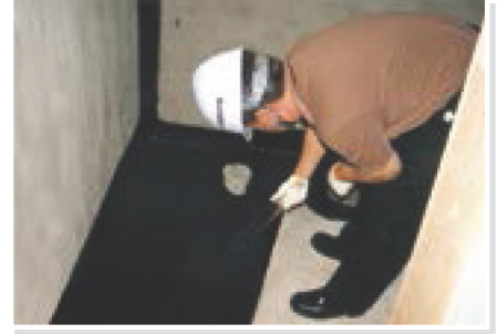
(화장실 조인트 보강방수)
